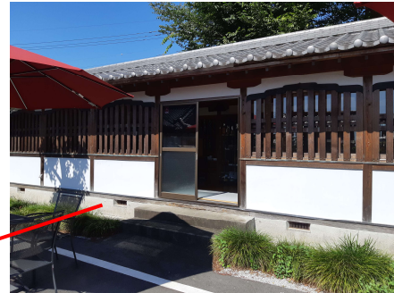
工事期間中の暫定入口 (客殿-本堂通路側)
