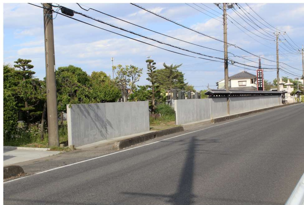
建設中の擁壁
