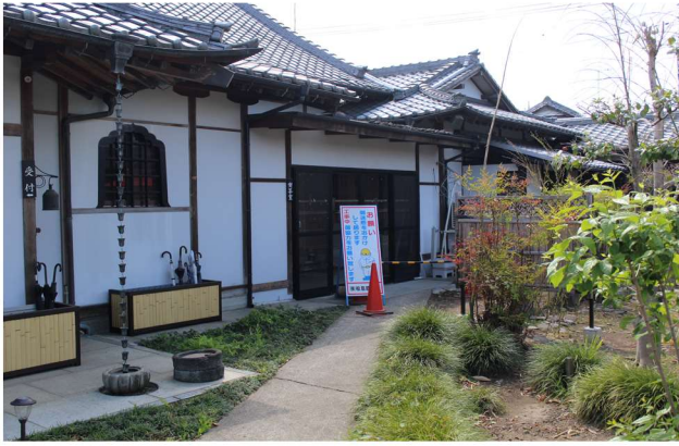
建設中の新寺務所
