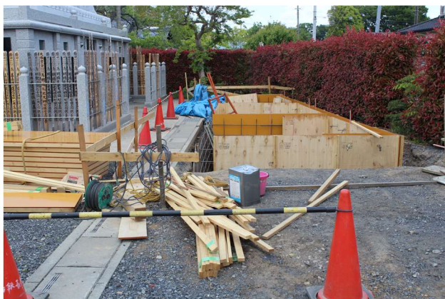
建設中の新納骨堂
