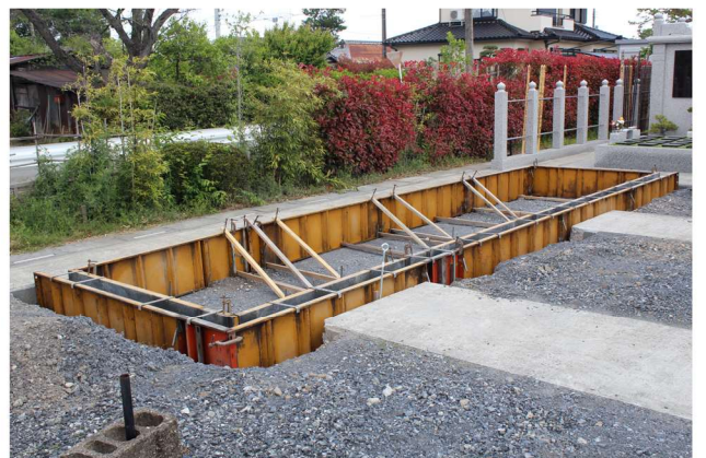
建設中の第三樹木葬墓地
